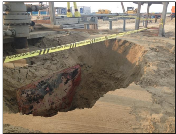
Рис. 1. Приустьевые провалы вокруг эксплуатационных скважин возникшие вследствие оттаивания ММП.
