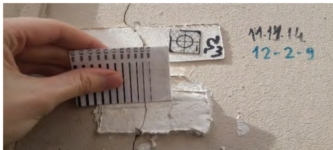
Фото 7.2. Фотофиксация гипсовых маяков №№ 5-2-2 (а) и 5-2-11 (б), установленных на ограждающие конструкции здания по адресу: ул. Большая Садовая, д.5, стр.2
