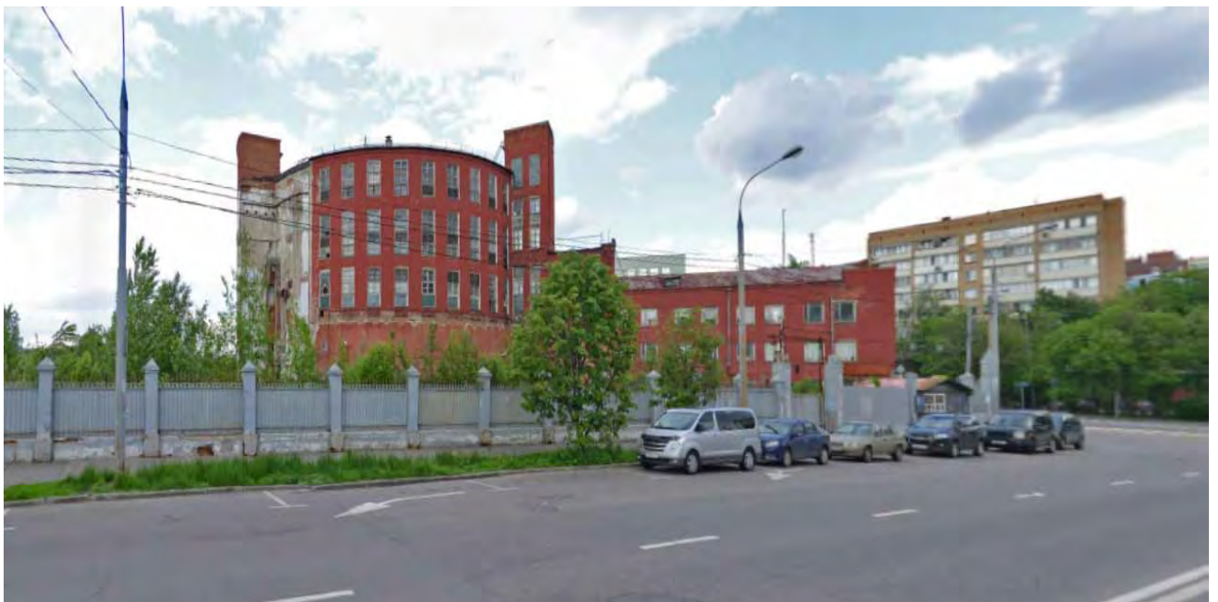
Фото. 5.1. Общий вид здания главного производственного корпуса
