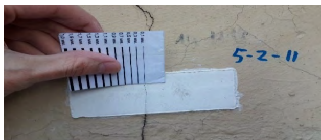
Фото. 7.1. Фотофиксация гипсовых маяков №№ 5-1-1 (а) и 5-1-20 (б), установленных на ограждающие конструкции здания по адресу: ул. Большая Садовая, д.5, стр.1
