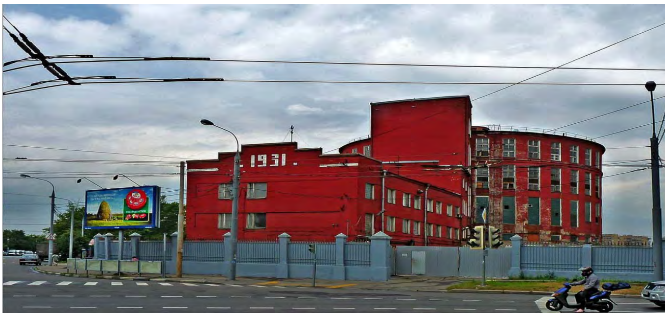
Фото 5.2. Торцевая часть здания главного производственного корпуса
