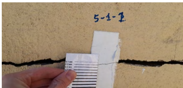
Фото. 7.1. Фотофиксация гипсовых маяков №№ 5-1-1 (а) и 5-1-20 (б), установленных на ограждающие конструкции здания по адресу: ул. Большая Садовая, д.5, стр.1
