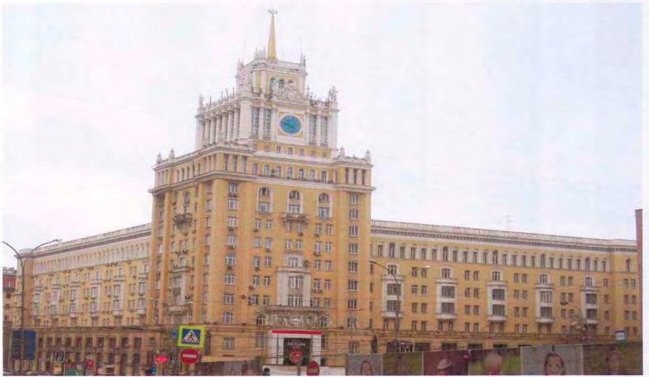
Фото 5.6. Главный фасад здания гостиницы «Пекин»
