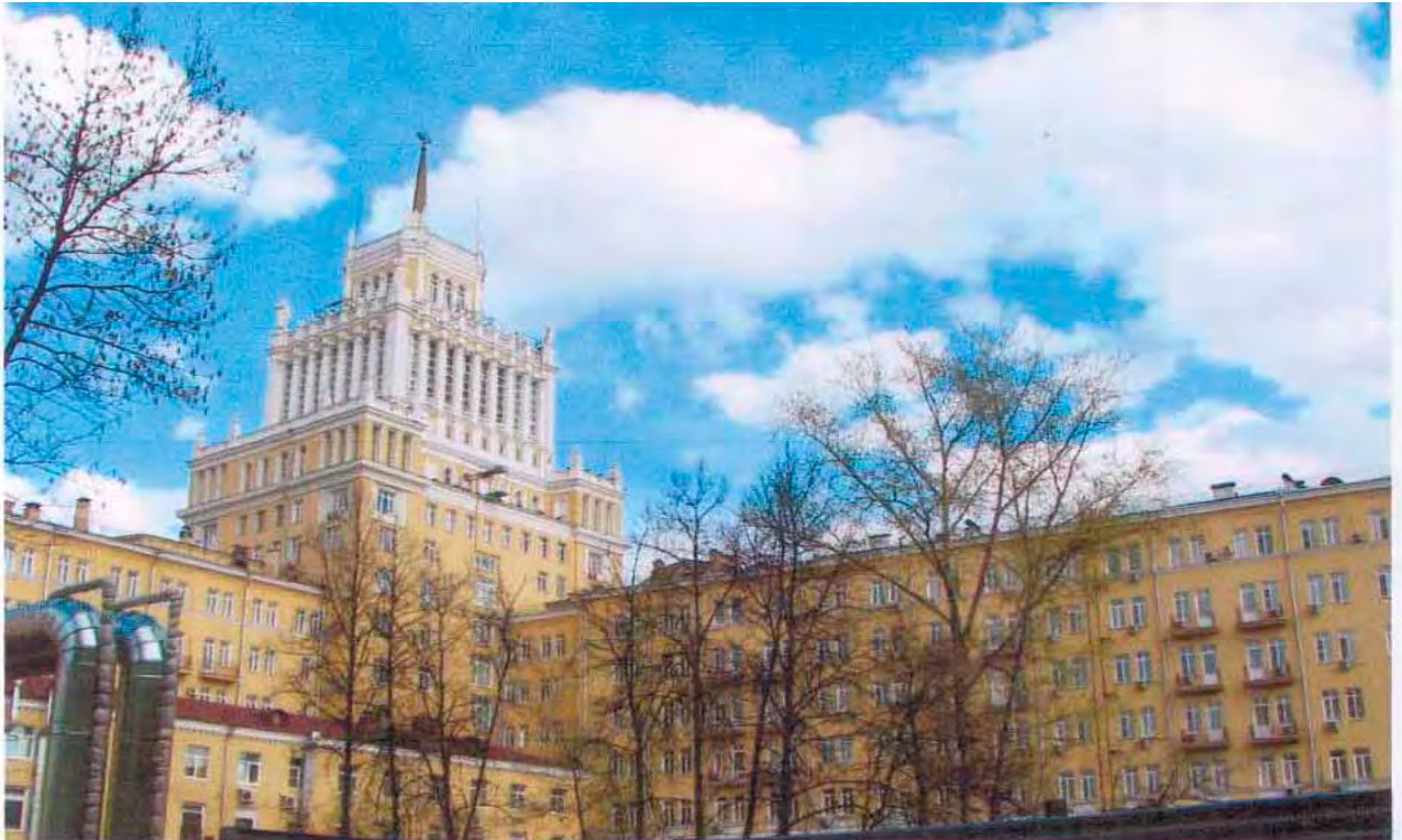
Фото 5.7. Главный фасад здания гостиницы «Пекин»
