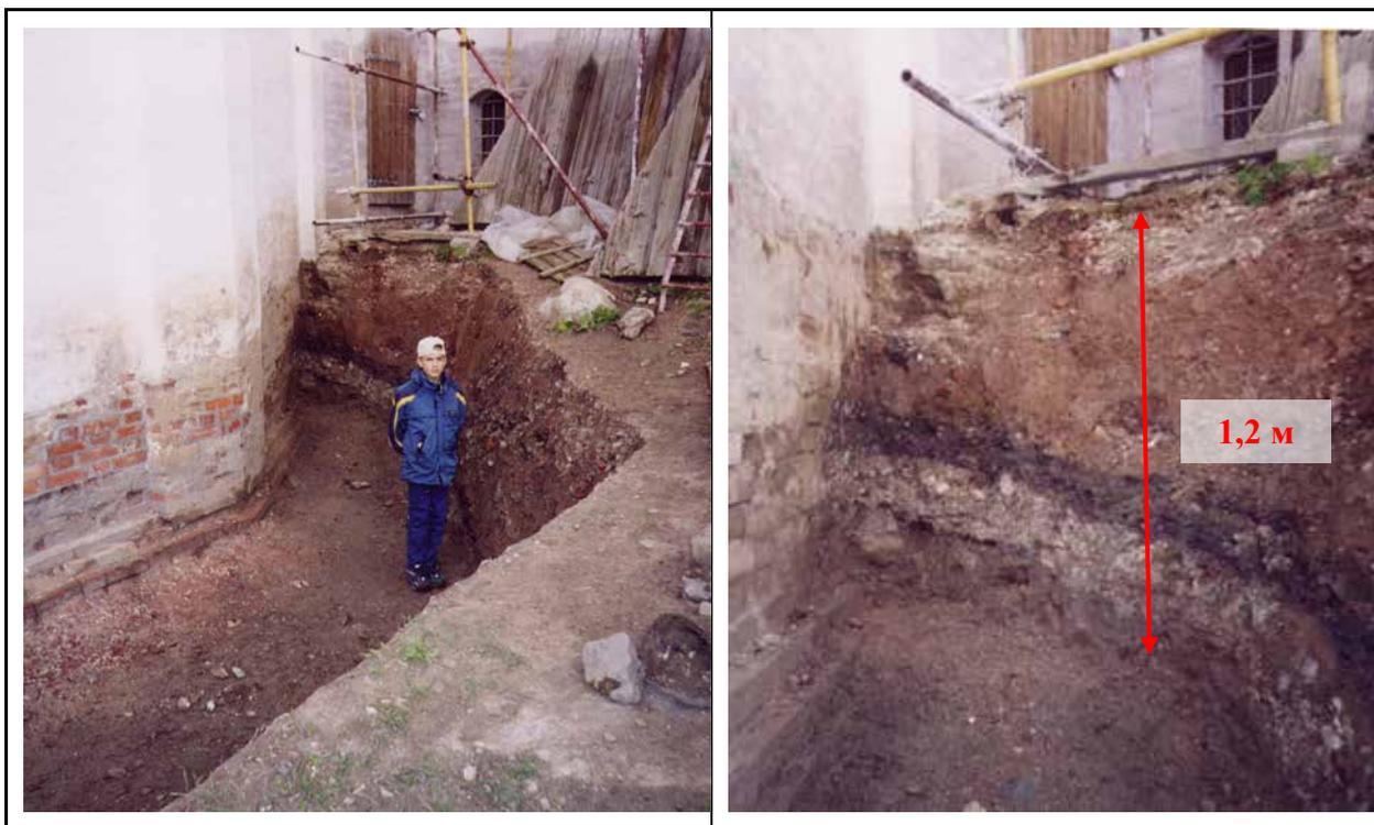
Фото 19, 20. Характер напластования грунтов культурного слоя (техногенный грунт) в стенке траншеи у восточной стены ц. Введения
