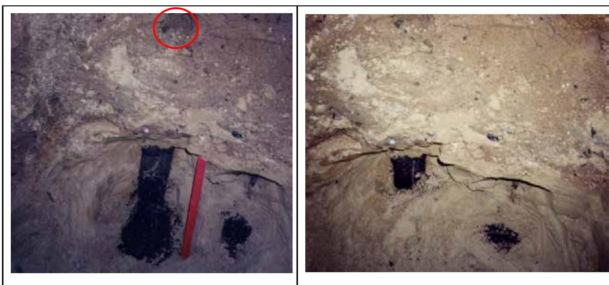
Фото 36, 37. Стаканы от сгнивших свай под валунным фундаментом на участке стены прилегающем к Вологодской башне. Красным выделена полость от полностью сгнившей деревянной сваи
