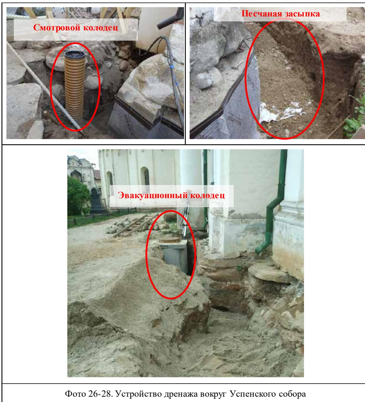
Для устранения увлажнения стен и поверхностей фундаментов предусмотрено устройство пристенного дренажа из двухслойного дренажного полотна.
