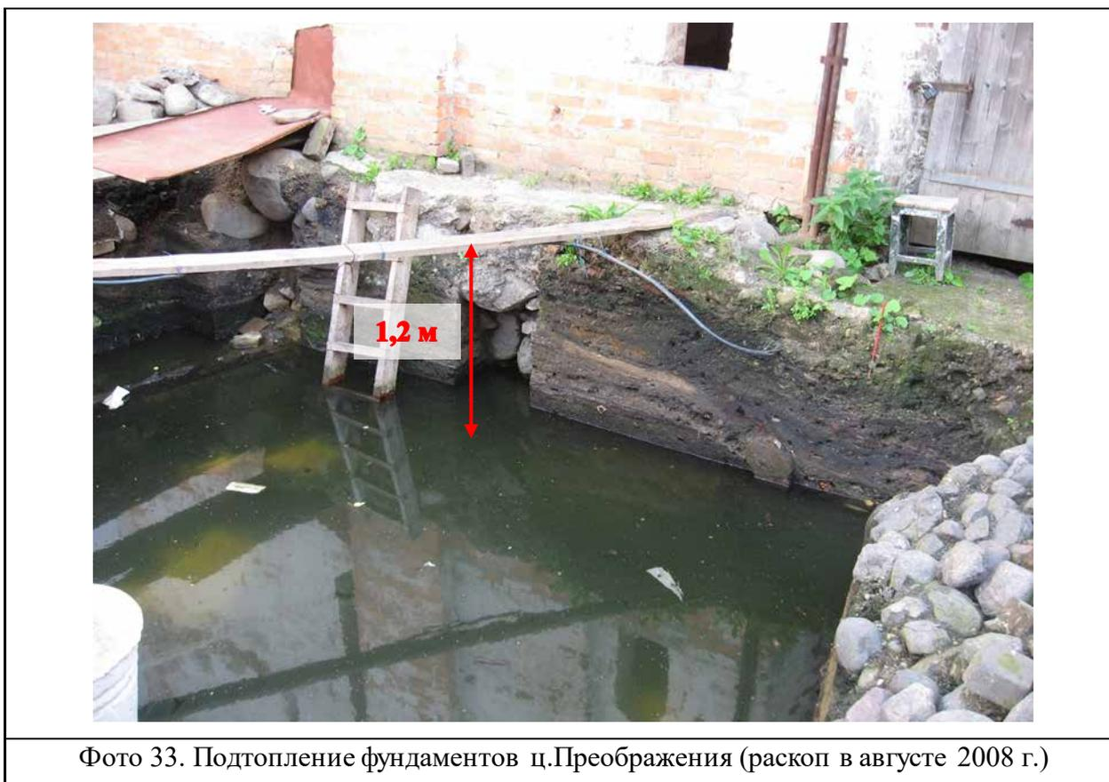
Фото 33. Подтопление фундаментов ц.Преображения (раскоп в августе 2008 г.)
