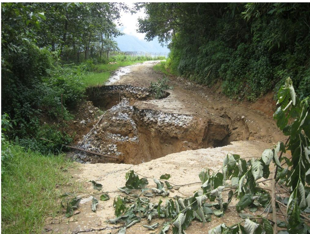
Рис. 4.9. Разрушение автодороги головной частью оползня в районе Шапа (2013 г.) [53].
