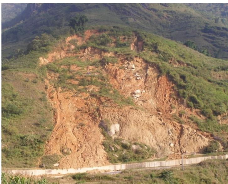
Рис. 4.3. Разрушение участка дороги в районе моста Монг Сен оползень
