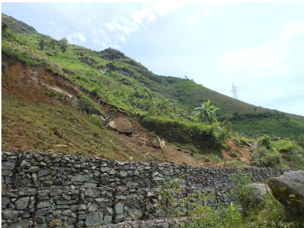
Рис. 4.12. Габрионная подпорная стенка в районе Батсат (2013 г.) [53].
