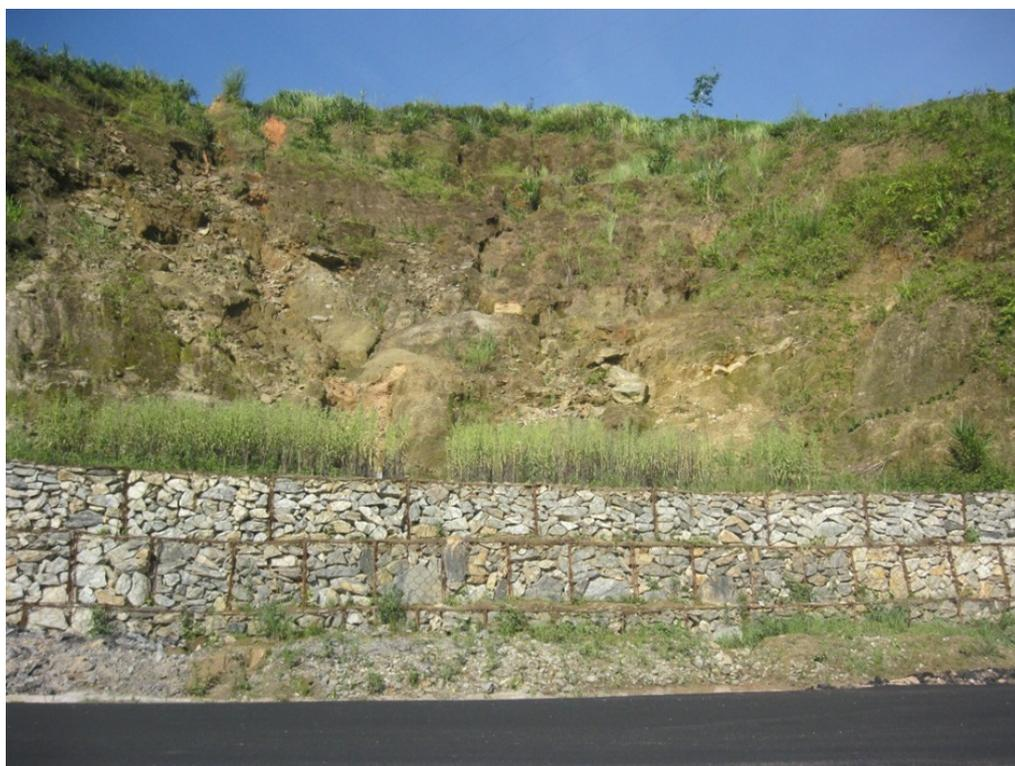
Рис. 4.13. Габрионная подпорная стенка в районе Шапа (2013 г.) [53].
