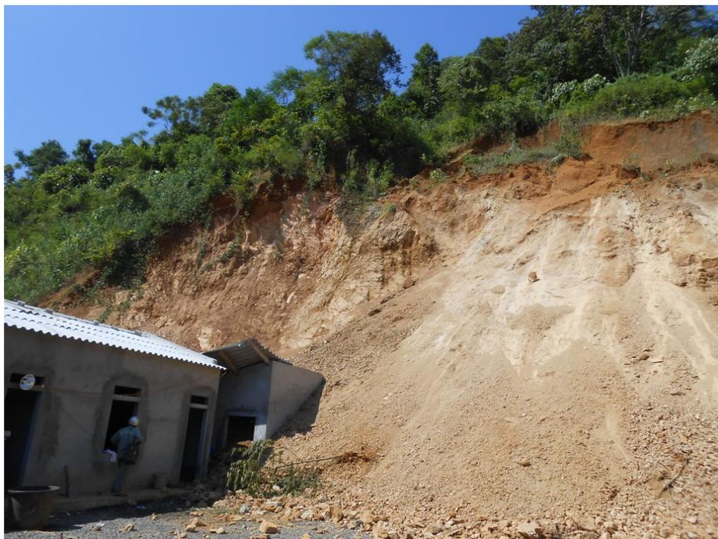
Рис. 4.5. Повреждение дома оползнем в районе Батсат (2013 г.) [53].
