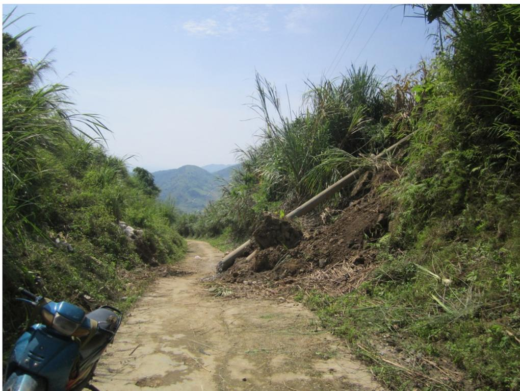
Рис. 4.7. Разрушение автодороги и ЛЭП из-за оползня в регионе Батсат (2013 г.) [53].
