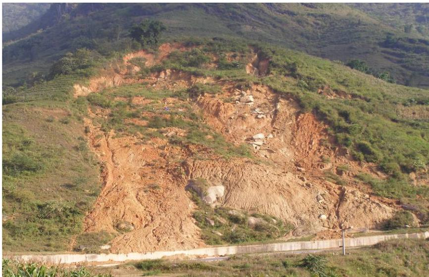
Рис 2.10. Фотография оползня в районе моста Монг Сен оползень в Чунг Чаи, Шапа (2012 г.) [77].
