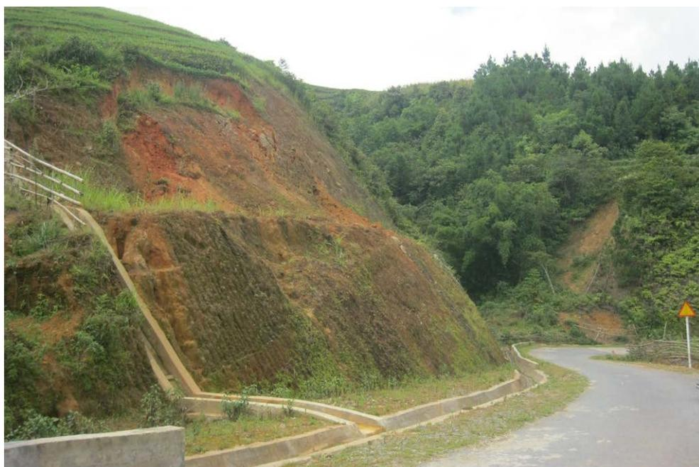
Рис. 4.10. Системы поверхностного водоотвода в районе Шапа (2013г.) [53].
