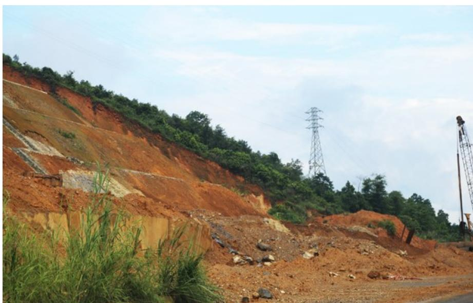
Рис 4.15. Реализация комплексных противооползневых мероприятий (террасирование склона, строительство подпорных стенок, создание дренажной системы) на участке автодороги Нойбай – Лаокай (2016 г.) [166].
