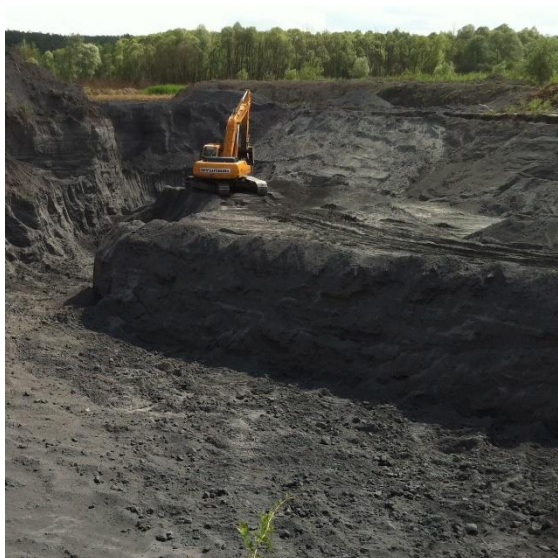
Рисунок. 1. Разработка золошлакового отвала Алексинской ТЭЦ в Тульской области.
