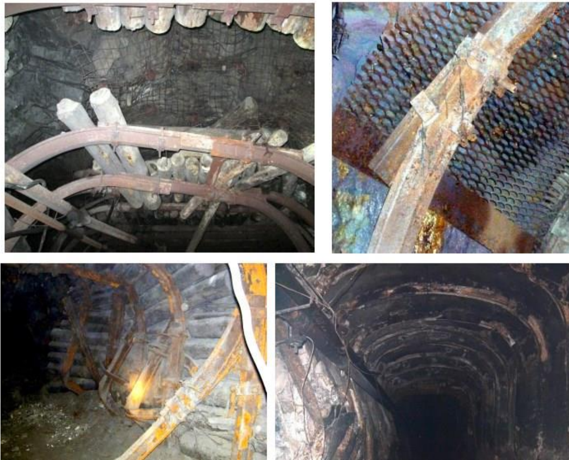
Рисунок 3. Примеры повреждения крепи
