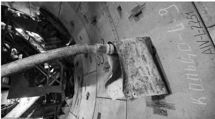
Рис. 1. Первичное нагнетание цементно-песчаным раствором за обделку тоннеля
