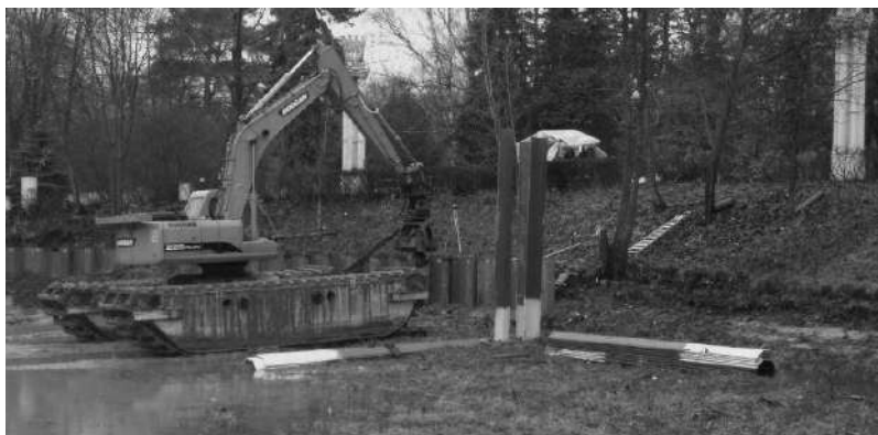
Рис. 1. Экскаватор-амфибия Doosan DX225LCA-SLR на установке шпунтов Ларсена.
